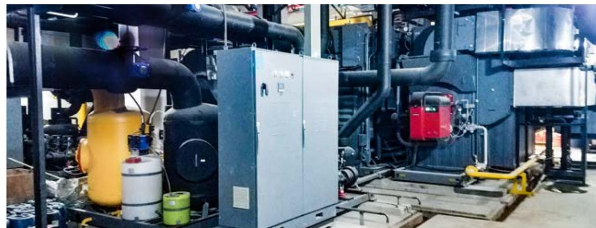
岳阳公司投资建设岳阳第二人民医院天然气分布式能源项目，通过燃气内燃机发电满足医院部分需求，余热通过溴化锂机组制冷，辅电空调进行冷热供应，同时配备燃气锅炉供应蒸汽。经测算，项目实施后减少排放二氧化碳255万立方米、一氧化碳11.78万立方米、碳渣1182吨、飞灰7879吨。
